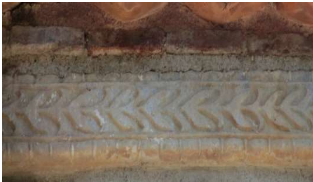
Εικόνα 32: Τμήμα του μεσαίου εξωτερικού γείσου στην νότια πλευρά του ναού
